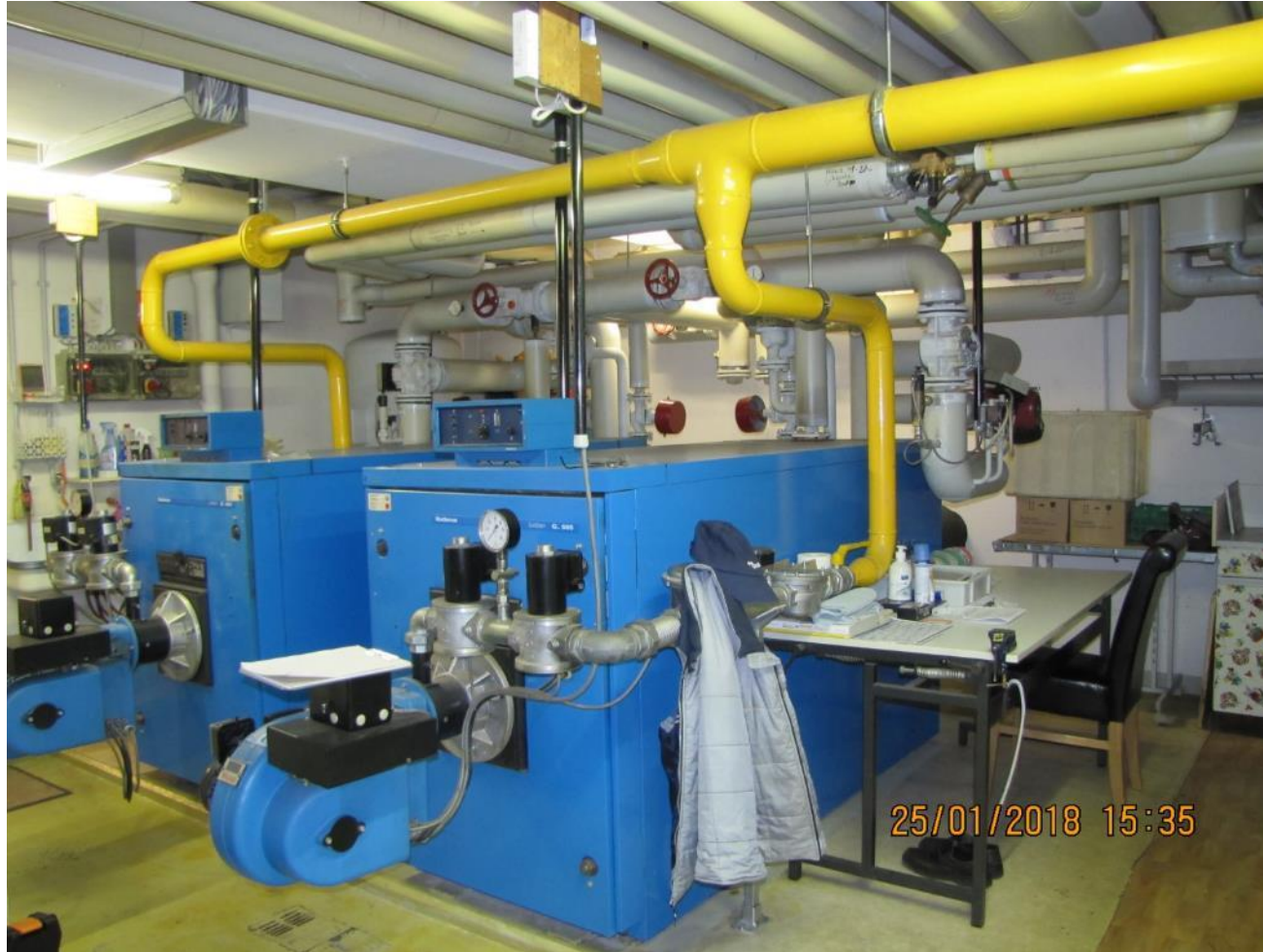
Defekter Gaskessel
